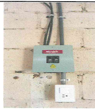
Foto 6: remplazo de linea electrica y accesorios
