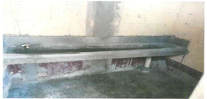
Foto 4: instalacion de miquitorio
